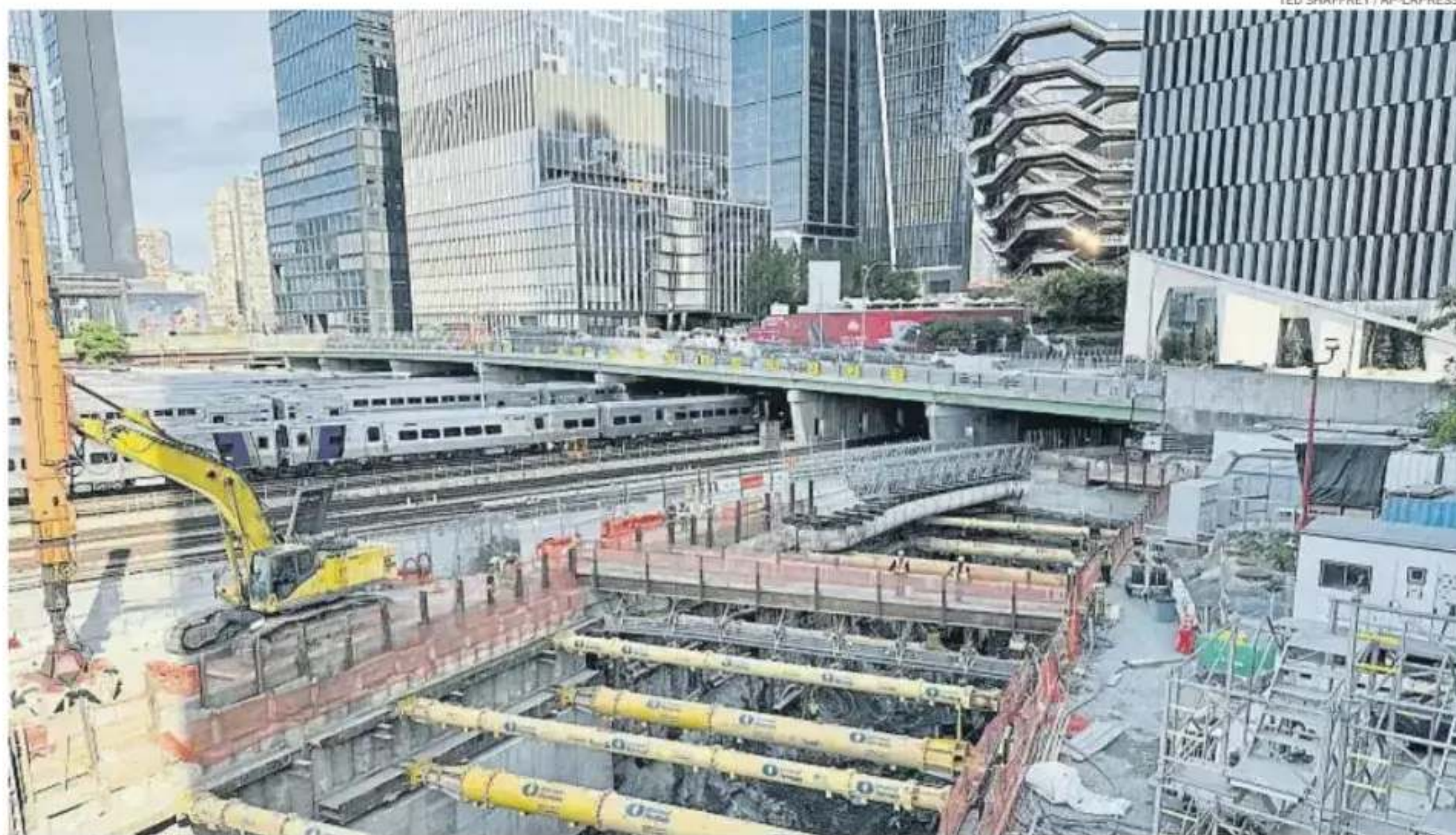
'Show the money'. Una jueza federal insta a la Administración Trump a desbloquear los 16.000 millones de dólares necesarios para construir un nuevo túnel ferroviario entre Nueva York y Nueva Jersey bajo el río Hudson
