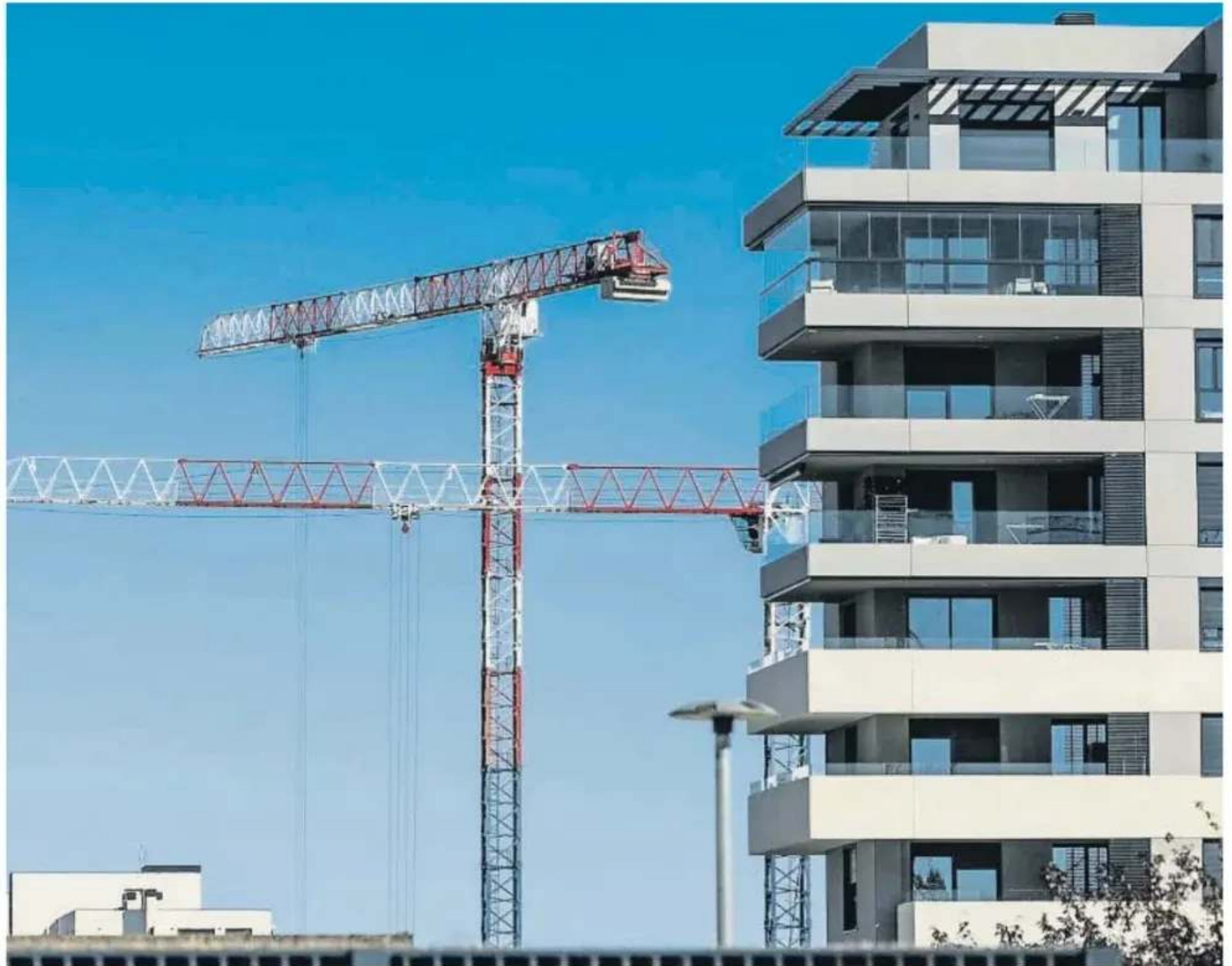
Un bloque de pisos recién construido en Madrid junto a grúas operando en un edificio contiguo
